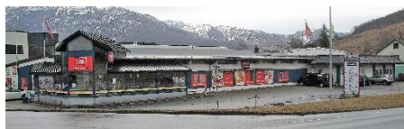
Vikeså Forbruk like før bygget ble revet i 2018.
